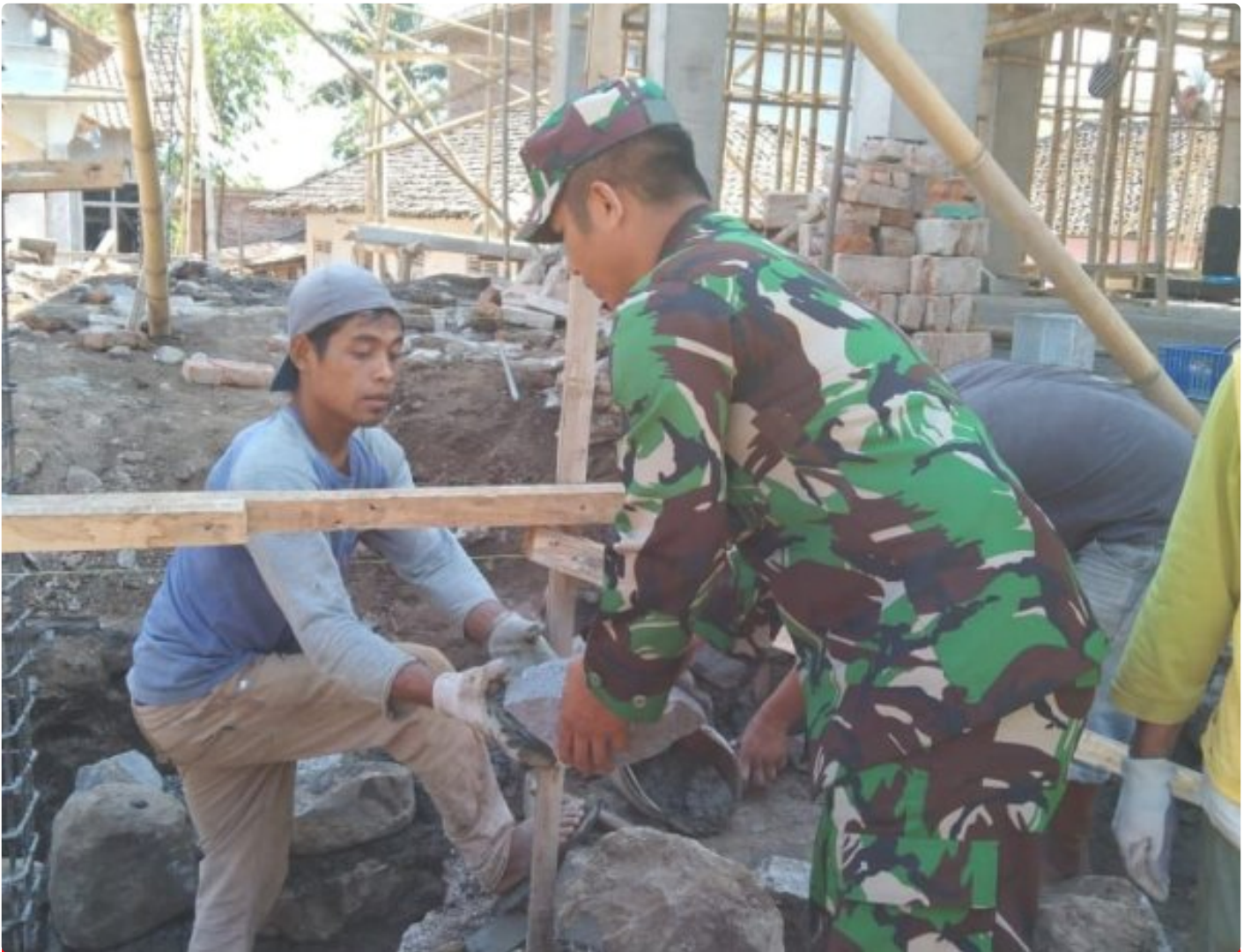
Serda Nasikin bantu pemasangan batu pondasi masjid
